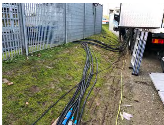
Vista laterale di autoarticolato con bi-gruppo elettrogeno e distesa di cavi
