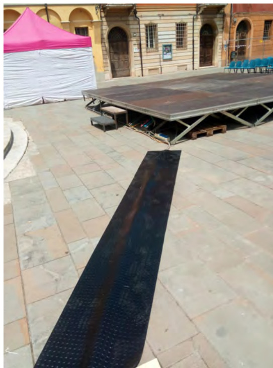
Passaggio di cavi mediante cavidotti
