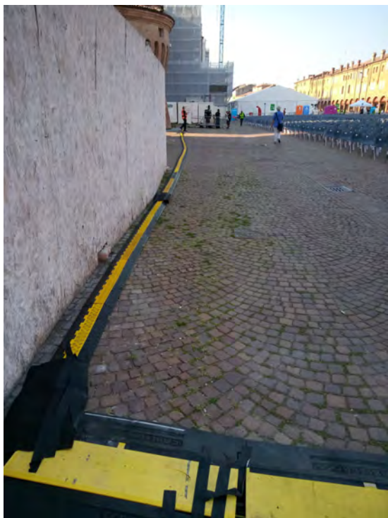
Passaggio di cavi mediante cavidotti
