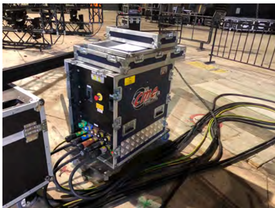
Power box a servizio delle varie sezioni elettriche con presenza di spine powerlock
