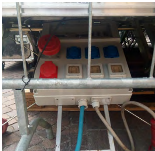
Power box a servizio delle varie sezioni elettriche
