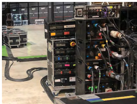
Power box a servizio delle varie sezioni elettriche con presenza di spine powerlock
