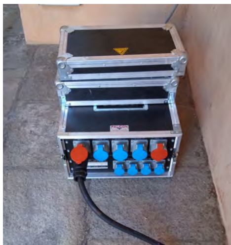
Power box a servizio delle varie sezioni elettriche
