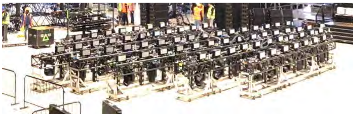
Americane pre-assemblate, ancora sui carrelli di movimentazione, pronte per essere agganciate e sollevate in quota.
