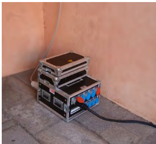
Power box a servizio delle varie sezioni elettriche
