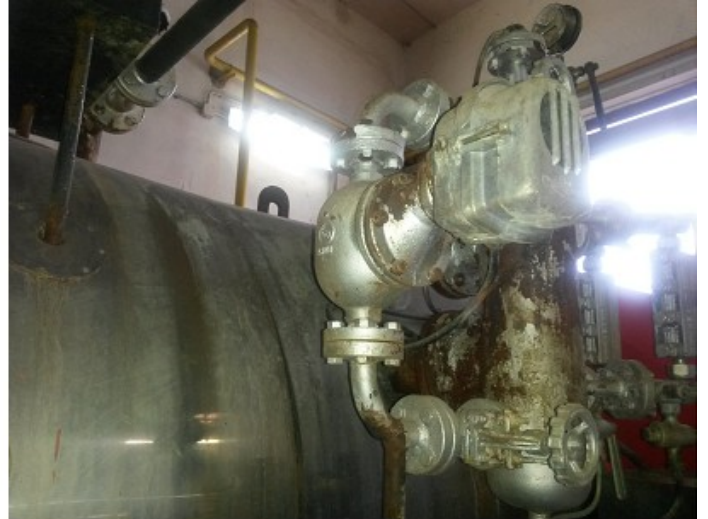
Regolatore di livello di tipo discontinuo del tipo a galleggiante
