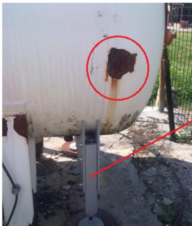
Cedimento delle selle d'appoggio del serbatoio per estese e profonde corrosioni
