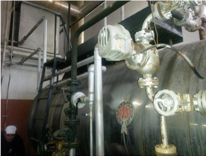
Regolatore di livello di tipo discontinuo del tipo a galleggiante
