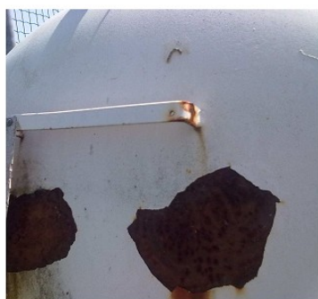
Cedimento delle selle d'appoggio del serbatoio per estese e profonde corrosioni
