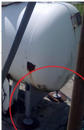
Cedimento delle selle d'appoggio del serbatoio per estese e profonde corrosioni
