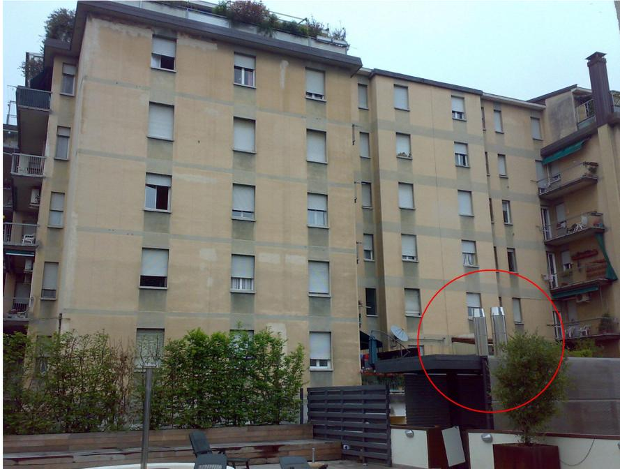
Fig. 6 - Camini di un impianto termico centralizzato
