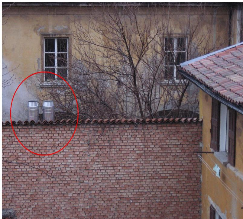
Fig. 3. Esempio di posizione errata dei camini
