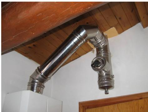
Fig. 3. Condotta del generatore di calore.
