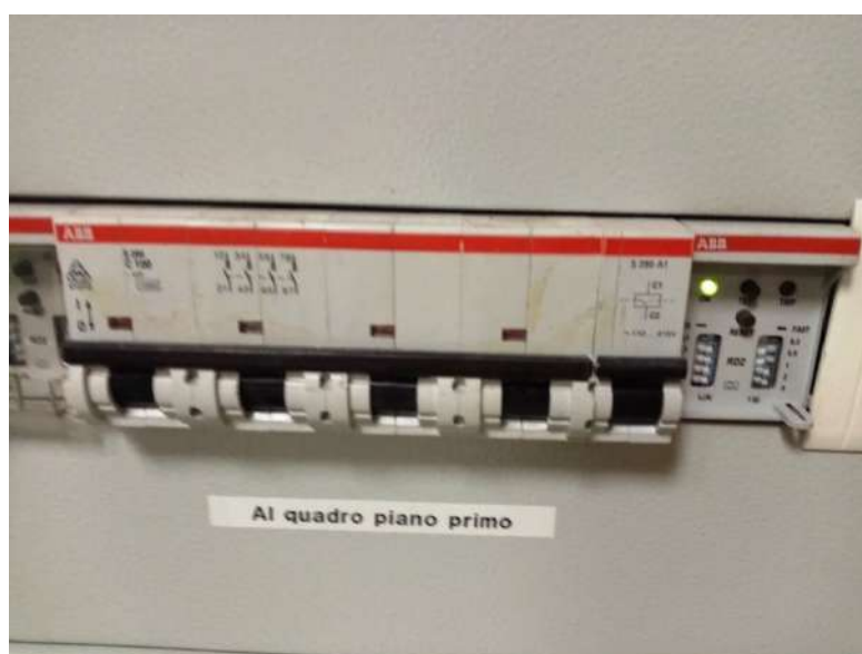
Figura 4 - Prot. linea PRIVILEGIATA - QE HMN PRIV. interruttore MTD 4xC100A Id 0,3 A 1sec classe A denominato "AL QUADRO PIANO PRIMO"
