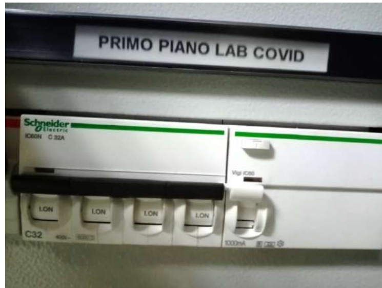
Figura 5 - Prot. linea CONTINUITA' QE HMN CONT. UPS interruttore MTD 4XC32A Id 0,1 A Sel classe A denominato "PIANO PRIMO LAB COVID"
