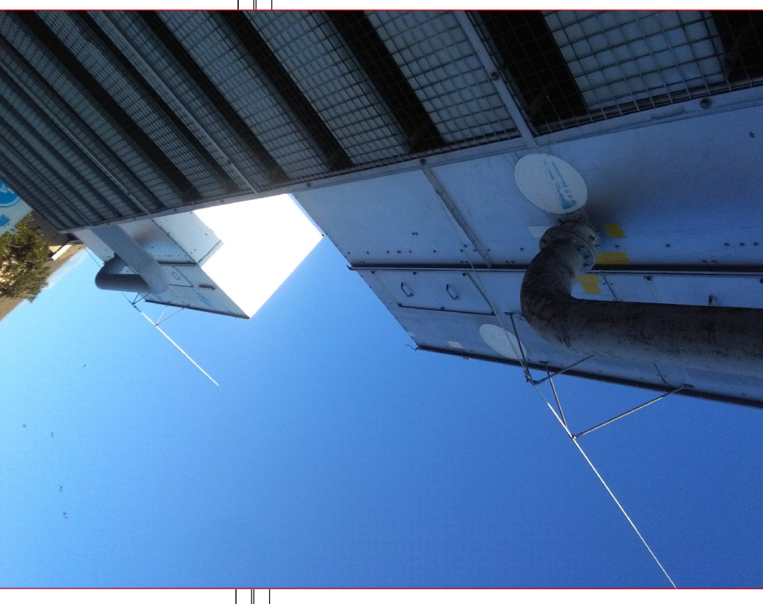
PARTICOLARE ASTE PARAFULMINE
