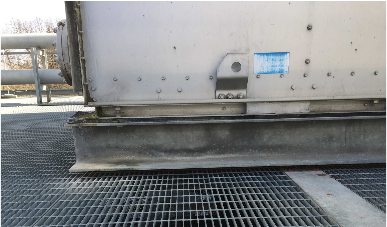
Appoggio puntuale, con sistemi antivibranti, sulle travi IPE450
