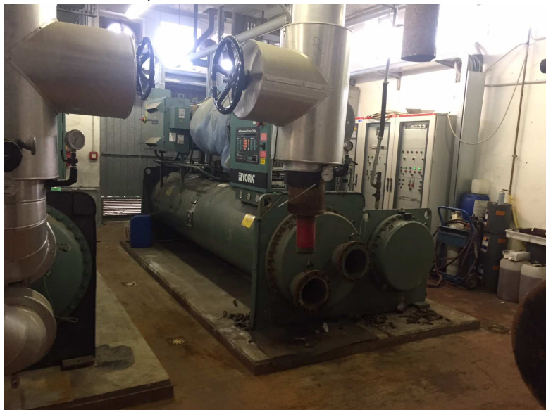
Dettaglio basamento oggetto di intervento; si notino le pilette a pavimento esistenti e i conseguenti fognoli e/o tubazioni da preservare e modificare se necessario con i lavori di contratto
