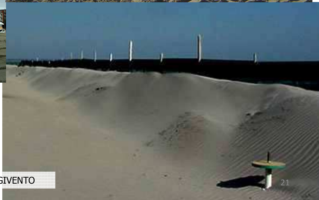
RECUPERO DELLA SABBIA POST VAGLIATURA PER IL SUCCESSIVO STENDIMENTO
