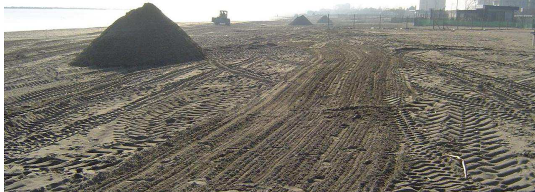
RECUPERO DELLA SABBIA POST VAGLIATURA PER IL SUCCESSIVO STENDIMENTO
